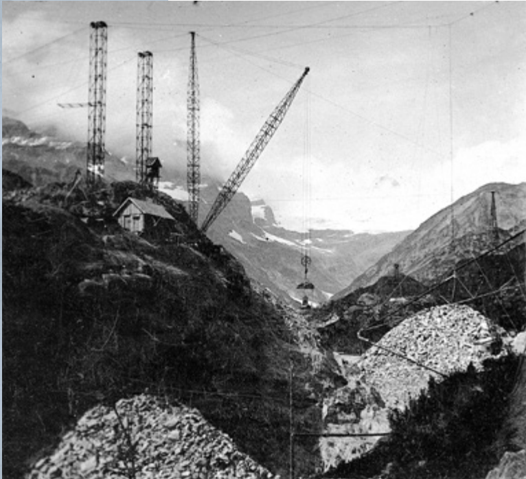
Zwischen 1920 und 1926 wird der Staudamm von Barberine in der Region Emosson gebaut, um die Eisenbahn zu elektrifizieren. ⑧
